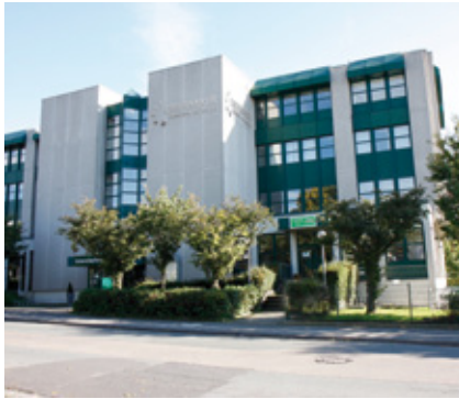
Stauerhaus – Campus Stauerland
